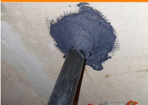
2. AAC Powerpanel/Hebel Wall Fill
